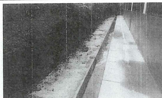
Foto 12: Loza de concreto terminada en su totalidad
